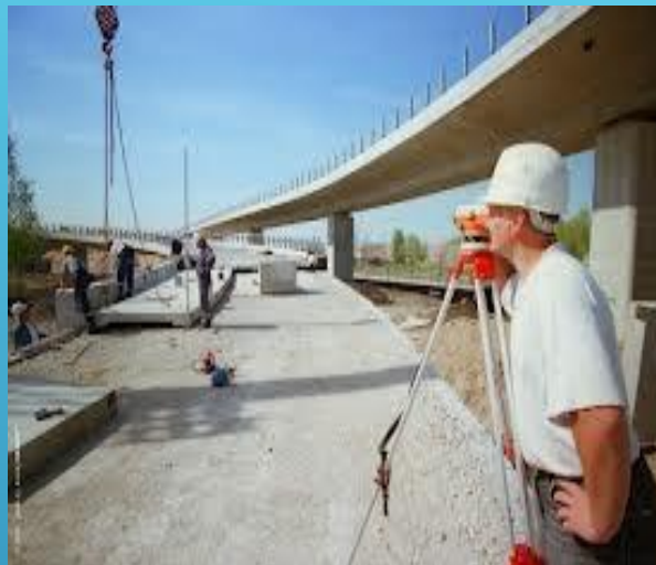
Мониторинг при строительстве
