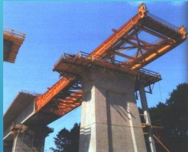
Строительство по базовому проекту
