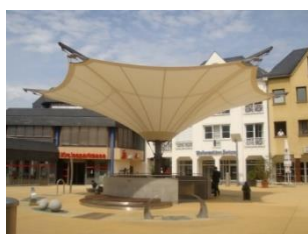
Trichterschirm Montabaur, Germany, source and ©: formTL ingenieure für tragwerk und leichtbau GmbH
