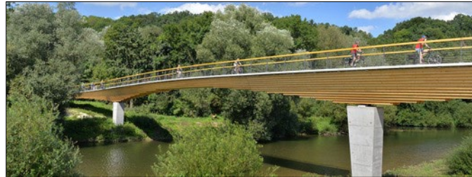
Blockträgerbrücke Neckartenzlingen; Source: holzbrueckenbau.com @ Fotograf Walther
