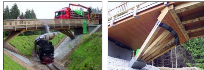
Sprengwerkbrücke Benneckenstein; Source: holzbrueckenbau.com
